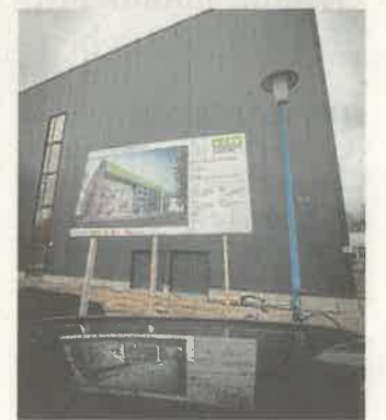
Das nächste Projekt ist die Kletterwand an der Außenfassade, die 2021 fertig sein soll.
